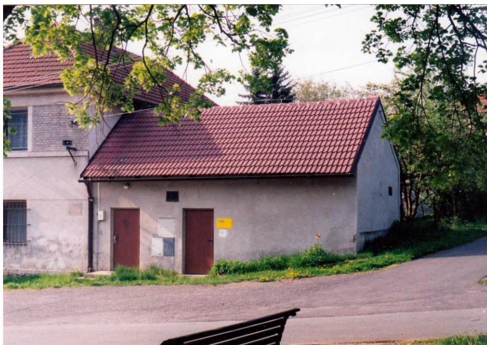
Dříve č.p.45 – Obecní domek, ale také > pastouška < , dnes je zde telef. ústředna Telecomu – jak je vidět, je to navázání na tradici existence telef. ústředny v naší obci.
