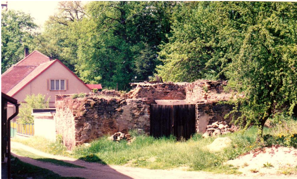
Ruiny bývalé hospodářské stavby přilepené ke komplexu, kde dříve stával pivovar a také četnická stanice z let 1886 a dále z období let 1922 až 1935. Ve zmíněné ruině choval tenkrát četník Bělonohý prase a slepice. Foto 2003.
