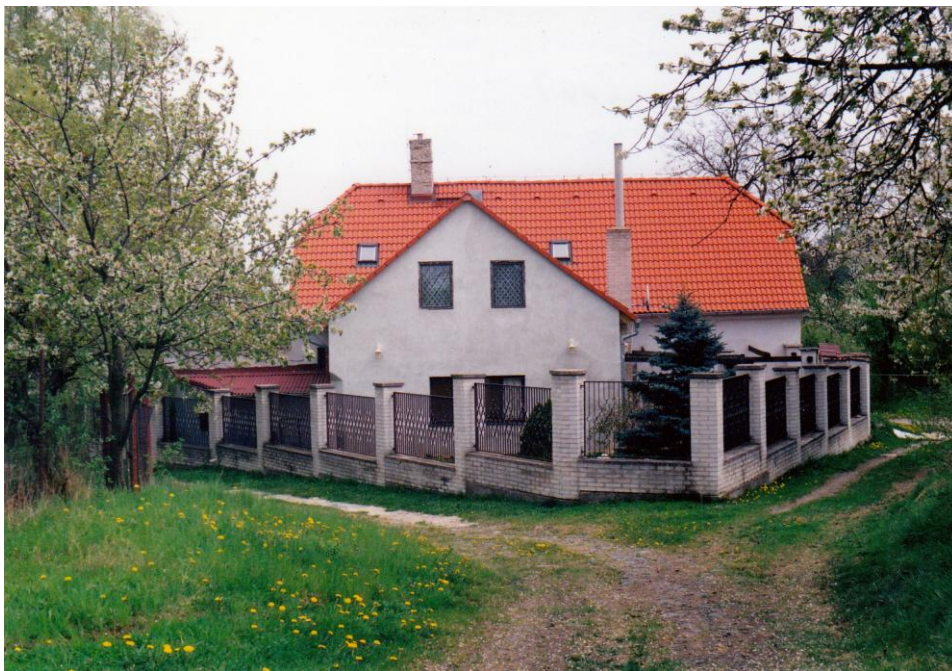
Foto z r.2003 – právě tu uvnitř probíhá renovace interiéru domu. Pohled od cesty na Kamýk - renovovaná o dva roky později.
